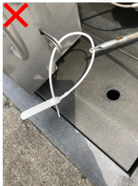
Zegel niet strak aangetrokken
